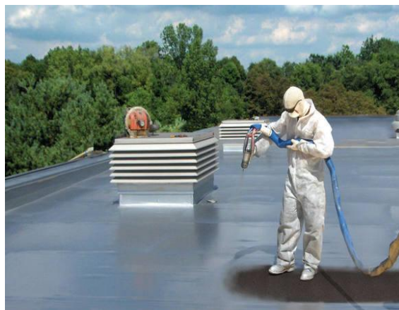
Рис. 2.2. Нанесення ППУ на суміщену покрівлю
